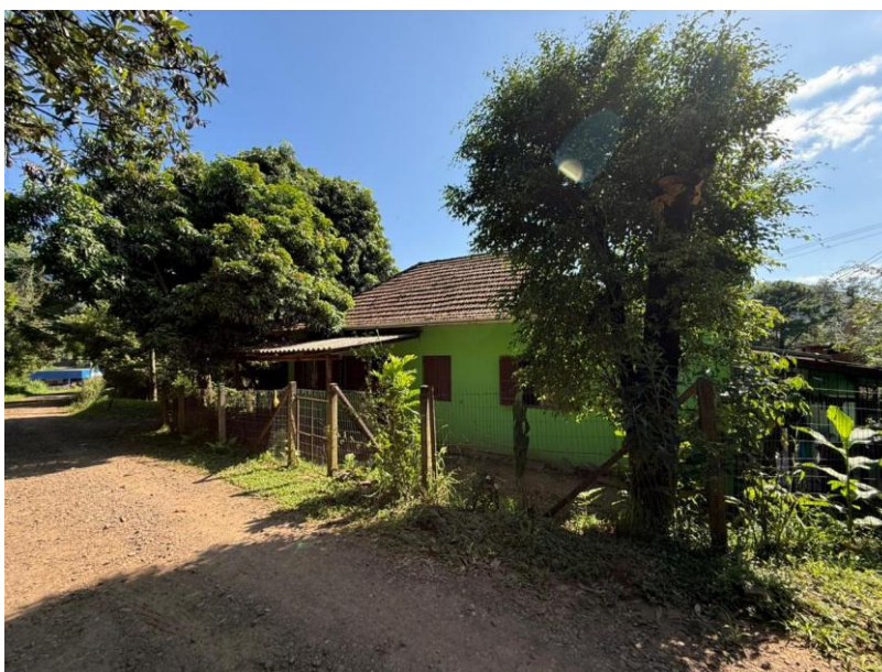
Figuras 02 : Vista edificação;
