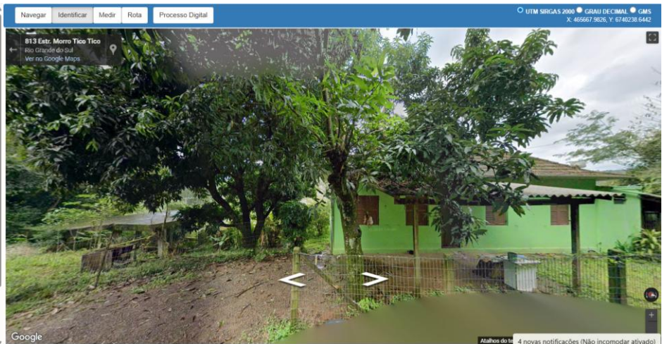
Figuras 06 : Vista edificação;
